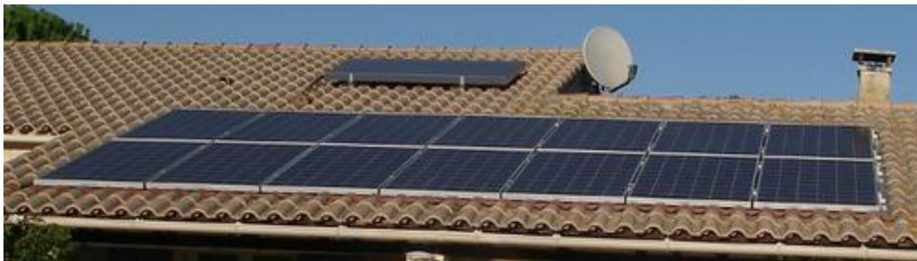
Photo d'un module solaire thermique surimposé avec une installation photovoltaïque « intégrée »
